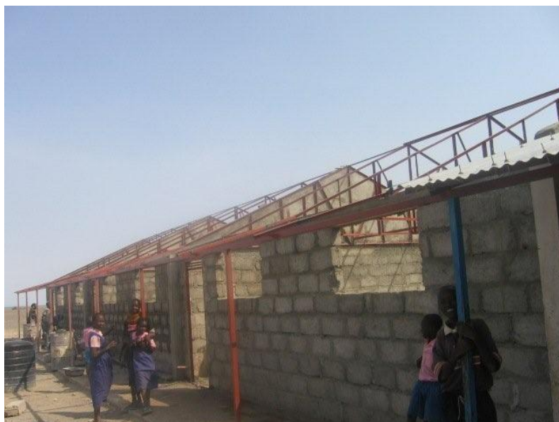
La scuola di Moite in fase di esecuzione. Le pareti in blocchi di cemento e le capriate metalliche per l'appoggio del tetto in lamiera
